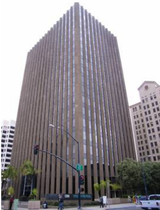
写真-1 サンディエゴ市 Civic Center。再開発局は 14 階です。
