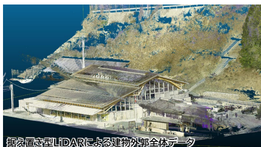
据え置き型LiDARによる建物外部全体データ
