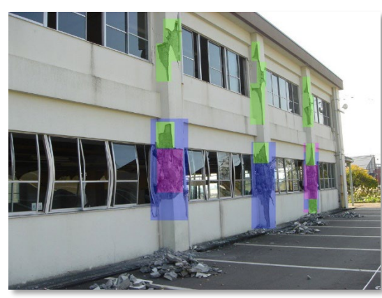
【AIが一時診断で変形・変状と認識した部位】
