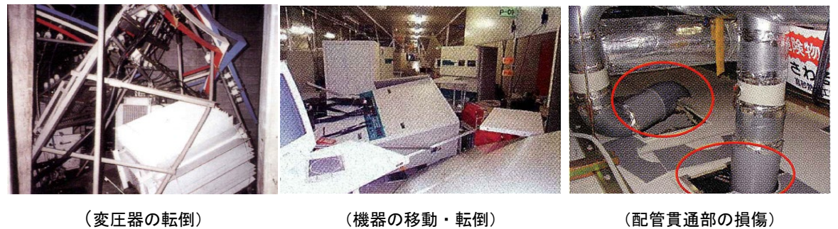
図 5 過去の地震による被害写真
